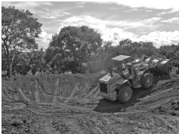
Construção de barraginha, no Município de Formiga, em Minas Gerais.
